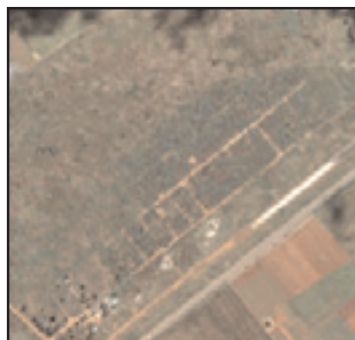
Porta Farm después del desalojo de sus habitantes y la demolición de las estructuras.
